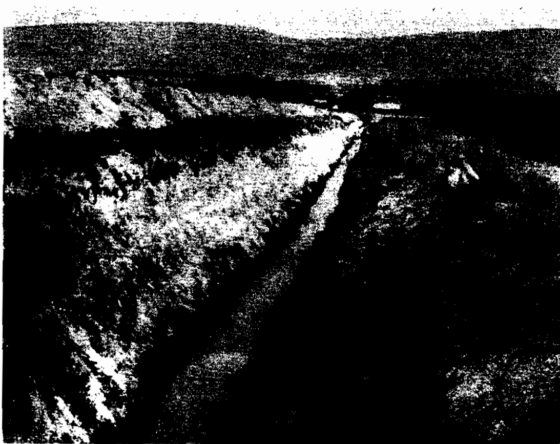
شکل ۱۲-۲: یک زهکش روباز بزرگ (۶ متر عمق) که لایه تحت فشاری را که در عمق ۵ متری زیر زمین بوده است قطع کرده است.
