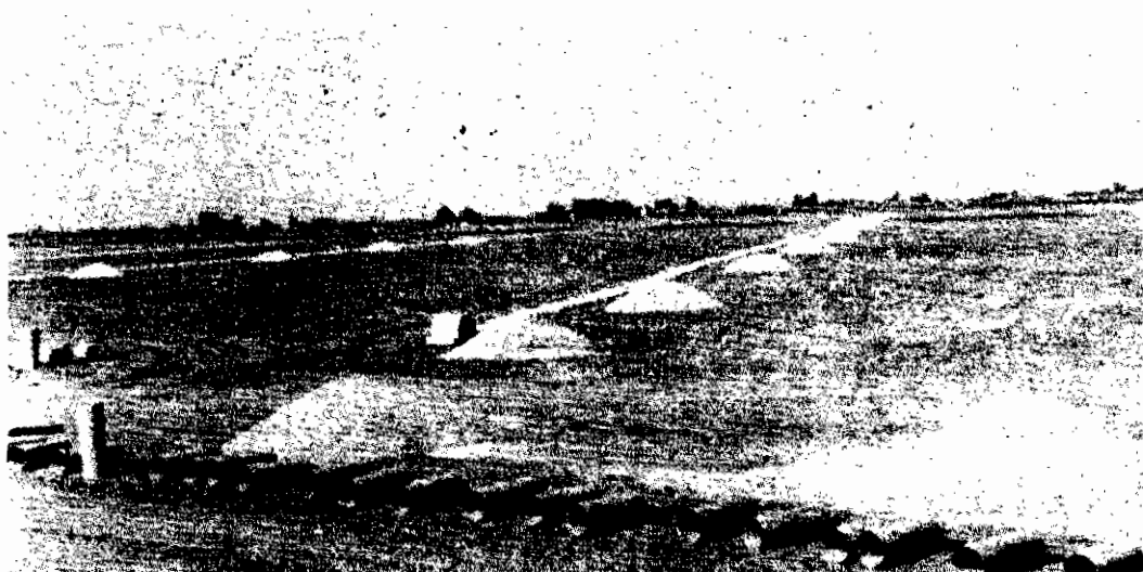
شکل ۱۱-۲۱: لوله های بتونی زهکش که قبل از نصب در مزرعه قرار داده شده اند توجه کنید که زهکش اصلی در جلو و زهکشهای جانبی در زمینه عکس می باشد . کپه های شن برای لایه پوششی اطراف لوله استفاده می شود .
